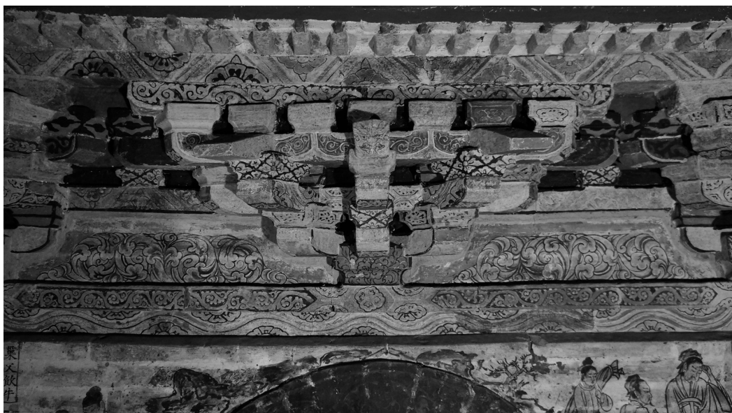
圖4 前室後壁門洞上方的五鋪作仿木磚雕斗拱
