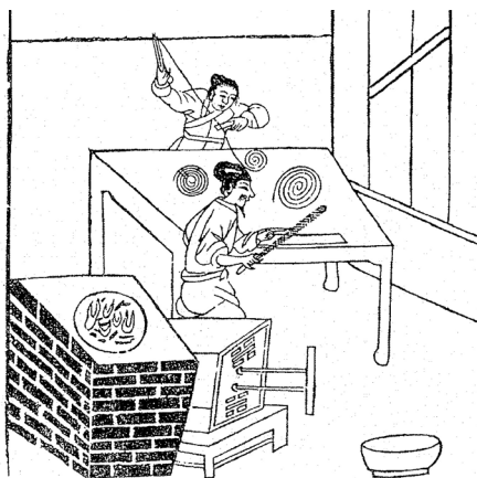
圖30 宋應星《天工開物》中〈抽線琢針圖〉的「抽線」的過程
