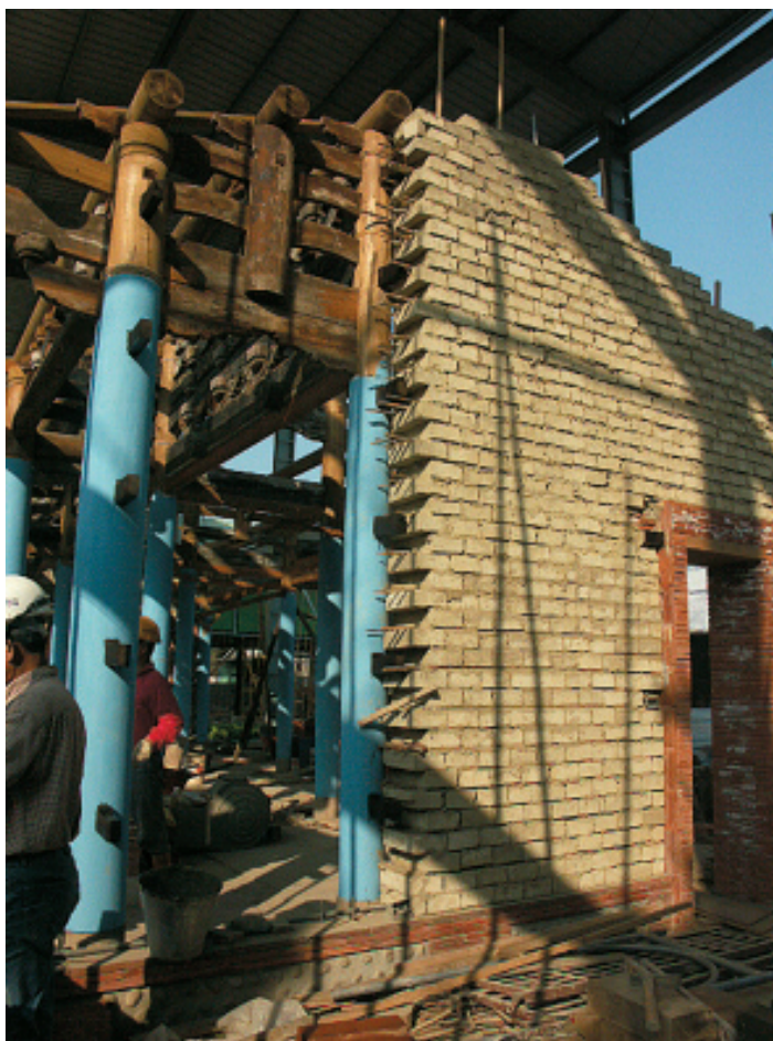
同宮保第一進正身內木構外土牆結構興造中的情形（2006.12）
