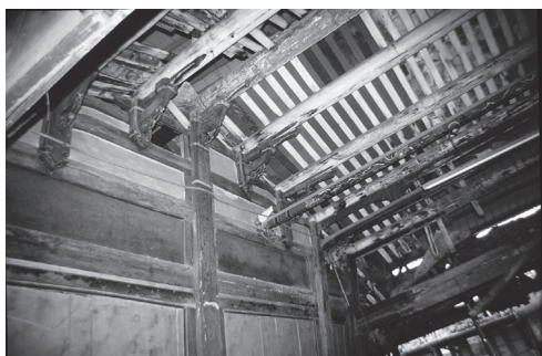
圖5 九二一地震後宮保第三進木構架還勉強站立不倒
