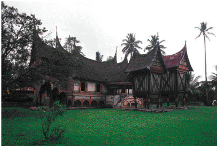
蘇門達臘島上米南卡保（Minangkabau）人民宅。上古時期中國長江流域以南至東南亞，普遍存在如米南卡保民宅的「長檐短脊」及「椿柱底架」之純木構干欄式建築型態（1995）
