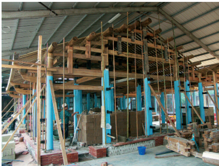
九二一震災後重建中的霧峰林家宮保第，外側土牆僅有基礎，尚未砌造牆身的第三進正身三開間木結構（2006.12）
